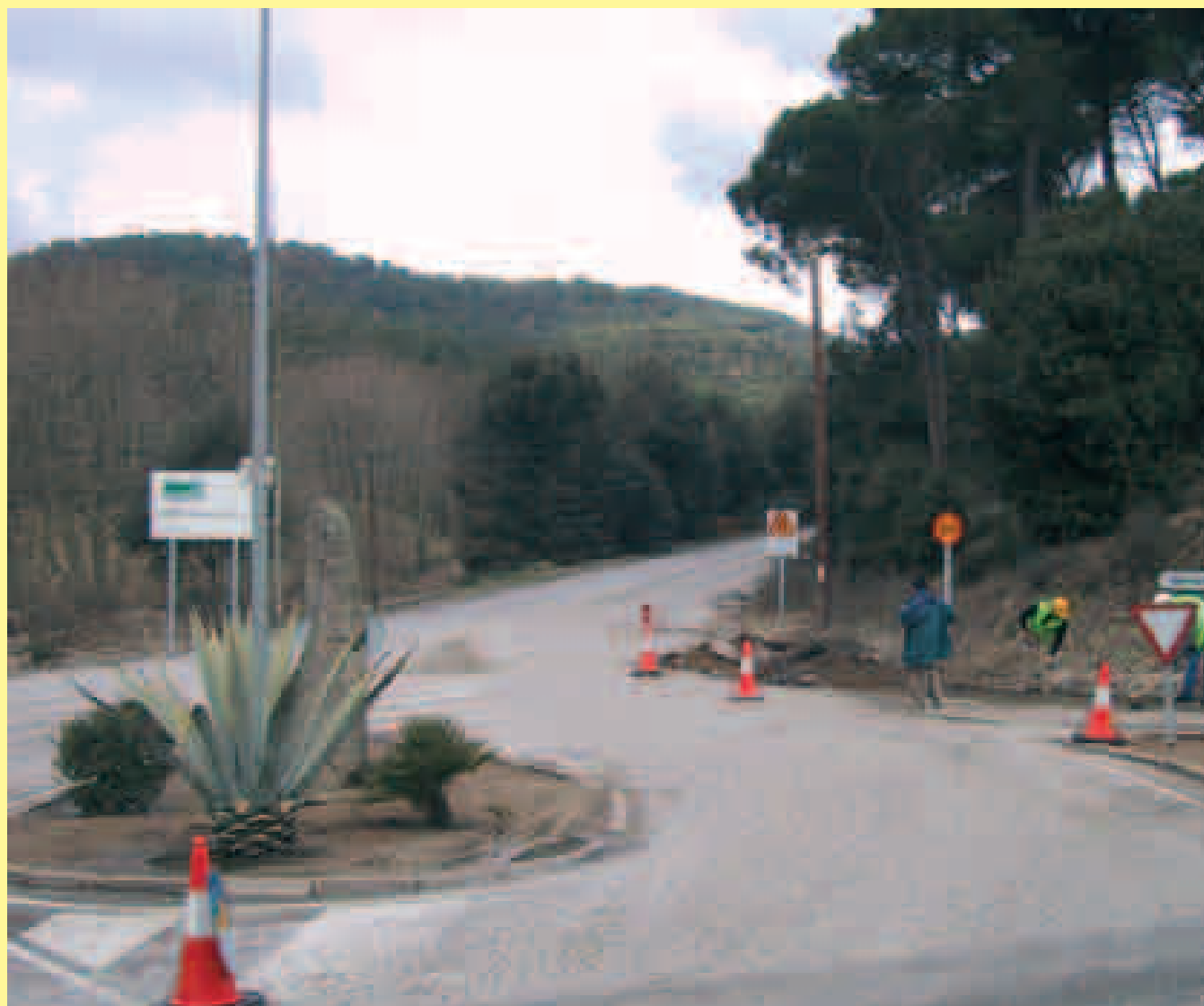
Aquest ajut serà per a la construcció de la rotonda, l'any 2007.
