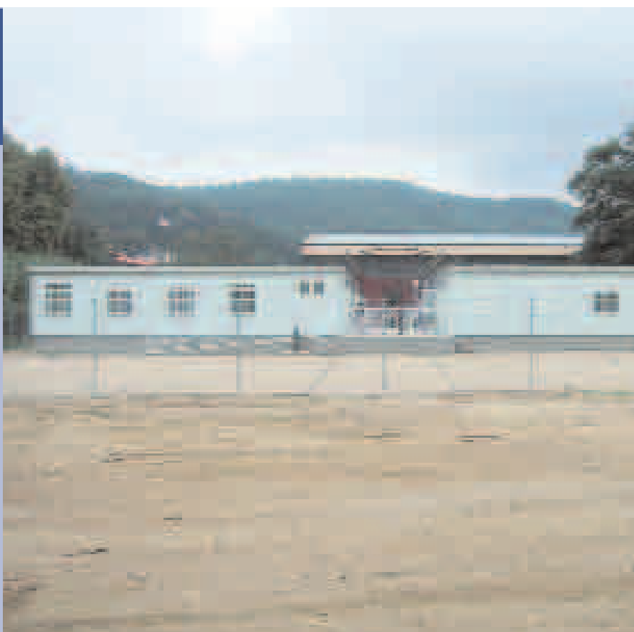
Els mòduls prefabricats on actualment hi ha l'institut provisional
